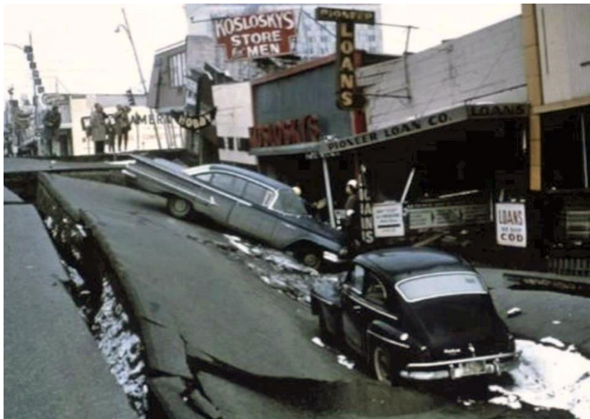
03.27 マグニチュード 9.2 のアラスカ大地震発生。 死者 131 名。液状化現象による被害が大きく、以後この現象の研究が活発化。
