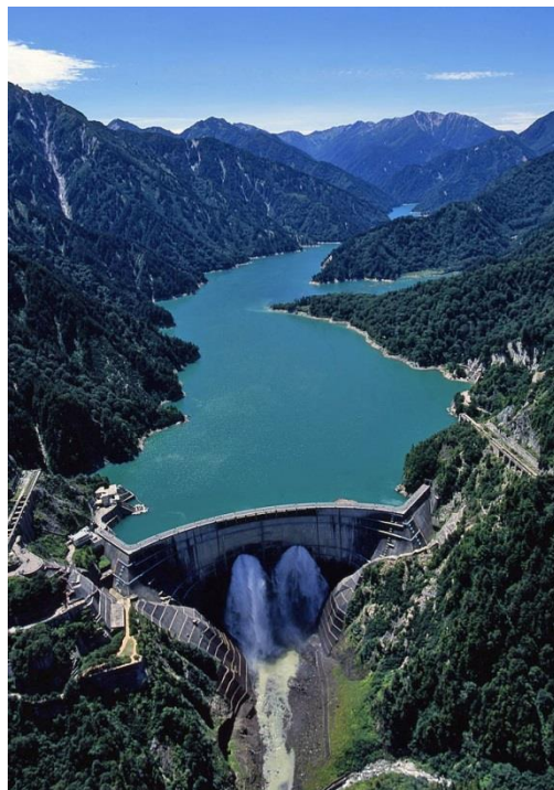
06.05 黒部川第四発電所が完成。 小説・映画・ドラマ「黒部の太陽」の舞台としても有名。
